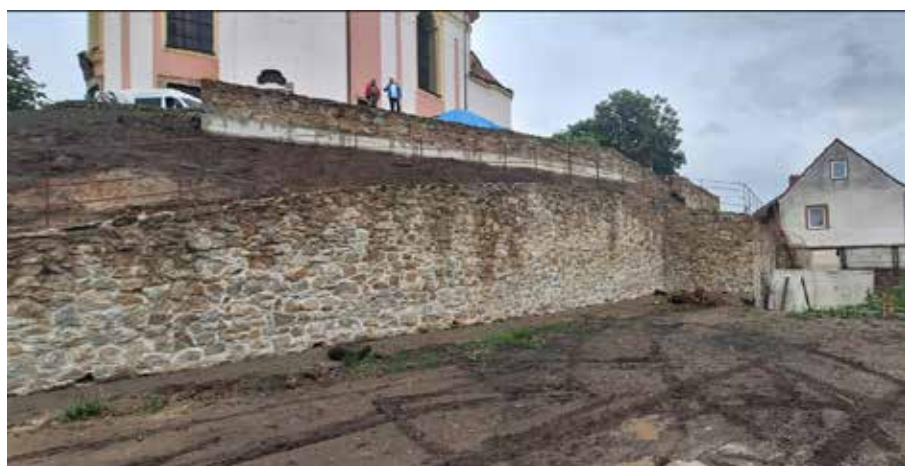
Obr. 8 - Příprava ploch pro založení vinic
