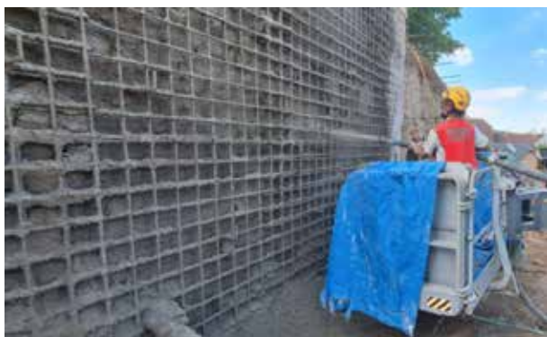
Obr. 4 - Realizace opěrné hřebíkové kotvené zdi v roce 2025
