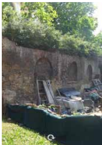
Obr. 5 - Stav před výstavbou r.6/2024
