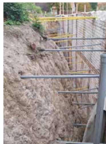
Obr. 3 - Realizace opěrné hřebíkové kotvené zdi v roce 2025
