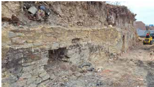
Obr. 1 Demolice staré zdi
