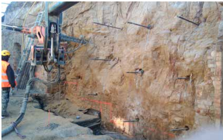
Obr. 4 Sanace skalního masivu, tzv. „hřebíkováním“
