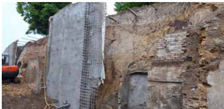
Obr. 5 Konstrukce nové železobetonové zdi
